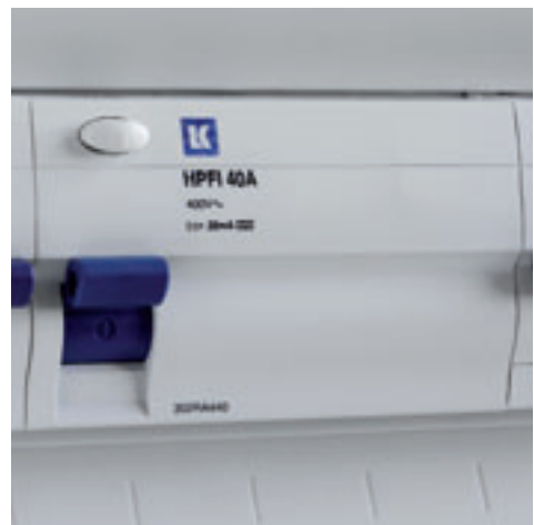
HPFI-afbryder med prøveknop øverst til venstre.
