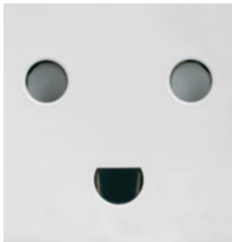
Pillesikringen ses som en spærring i lysegrå bakelit inde i stikkontaktens to øverste huller.
