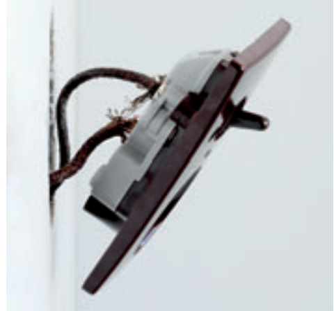
Gamle installationer har ofte stofledninger, hvis isolering mørner og smuldrer med tiden.
