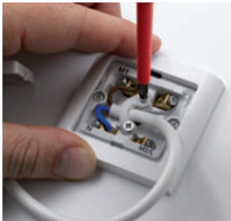
Aflastningsbøjler skal altid spændes grundigt, så der ikke er træk på selve lederne.
